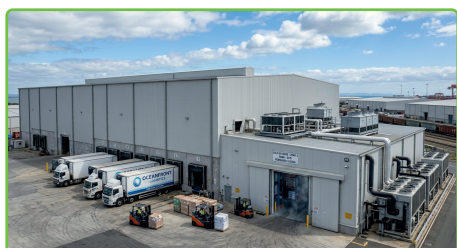
СКЛАДЫ ДЛЯ ХРАНЕНИЯ
