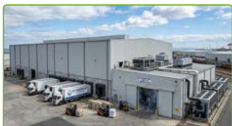
СКЛАДЫ ДЛЯ ХРАНЕНИЯ
